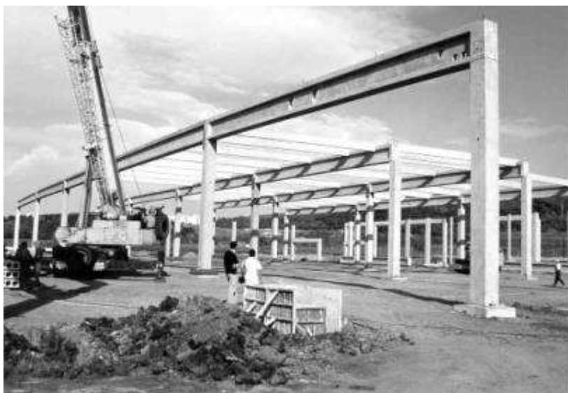
2. ábra. Metro Bukarest Voluntari szerkezete szerelés közben
