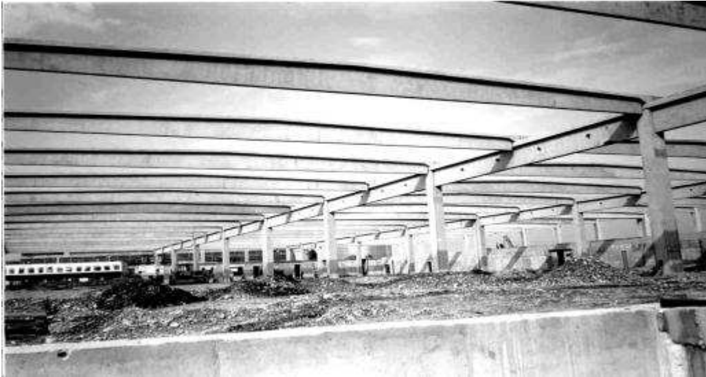
8. ábra. Kromberg gyártócsarnok Temesvár 15x22,5 m pillérhálóval
